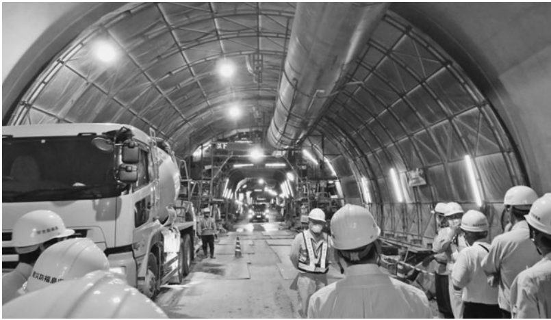
湯野上バイパス・(仮)3号トンネル内で掘削状況を学ぶ参加者ら
