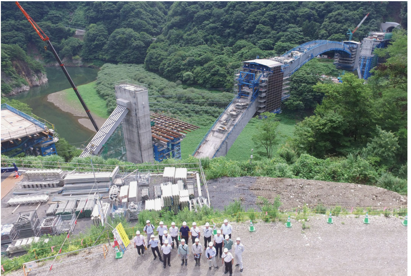
阿賀川を渡河する建設中の会津縦貫南道路 4 工区下郷大橋（道路視察会） 会津地区道路整備促進期成同盟会
