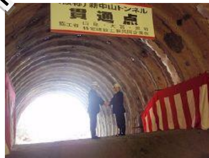
平成24年4月23日の新中山トンネル貫通式
