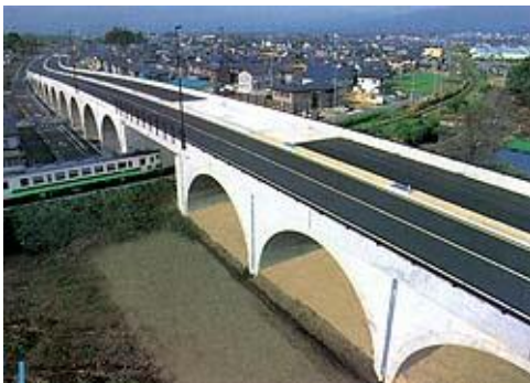
建設促進が望まれる「若松西バイパス」
