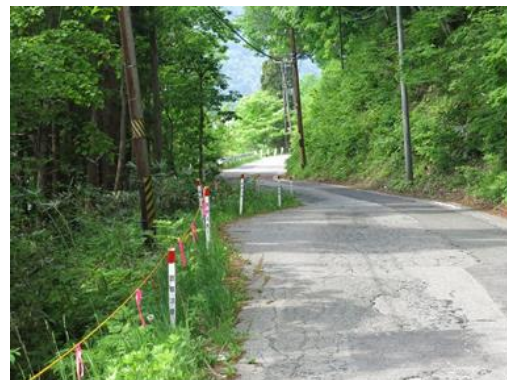
未整備区間（桧原・金山地区）
