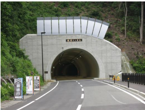
26年4月に完成した桧原トンネル
