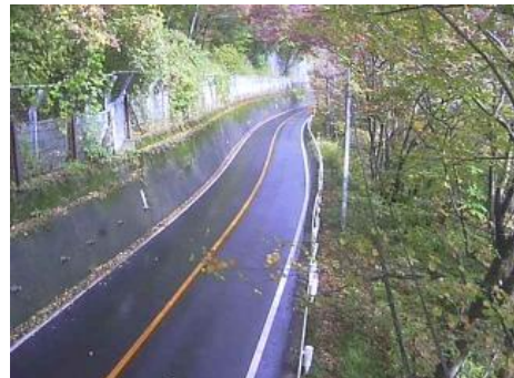
二川橋手前の狭隘な118号
