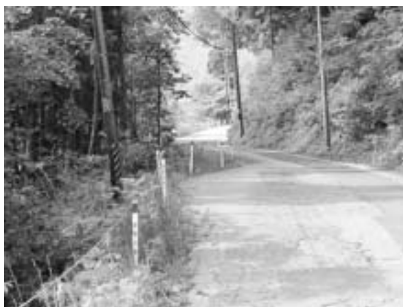
未整備区間（桧原・金山地区）
