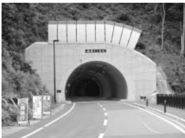
26年4月に完成した桧原トンネル
