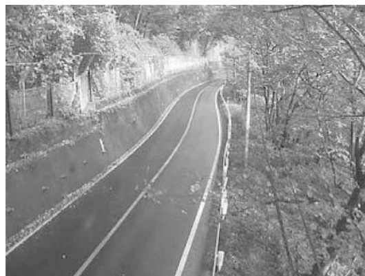
二川橋手前の狭隘な 118 号
