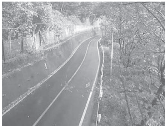
二川橋手前の狭隘な 118 号
