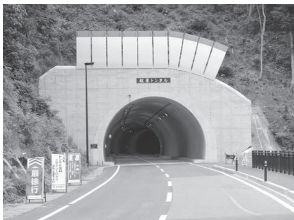
平成26年4月に完成した桧原トンネル
