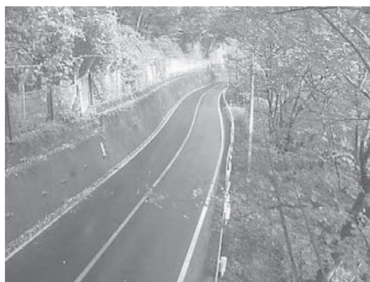
二川橋手前の狭隘な118号
