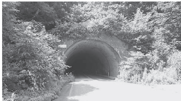
照明のない白沢トンネル
