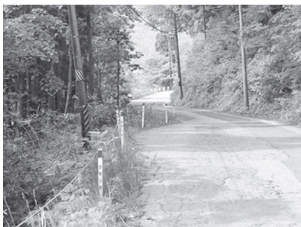
未整備区間（桧原・金山地区）
