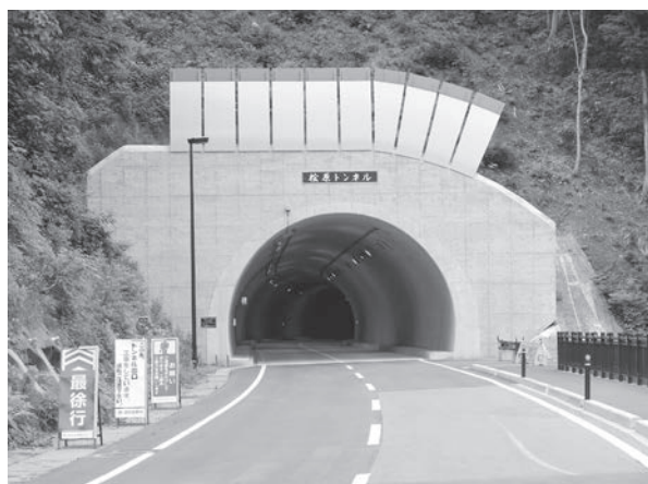
平成26年4月に完成した桧原トンネル
