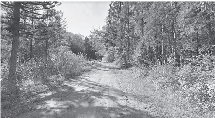
昭和村～只見間の吉尾峠の未整備・交通不能箇所
