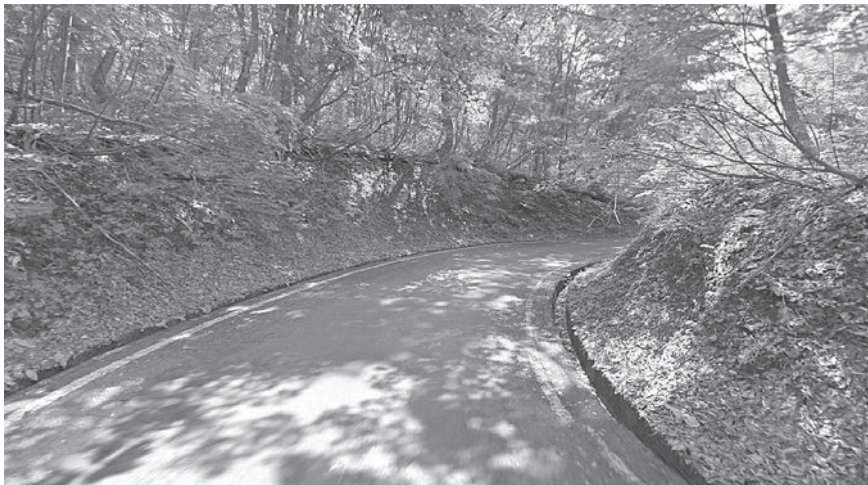
三島町から昭和村間の道路であるが、狭隘かつ屈曲で急勾配の箇所が多数
