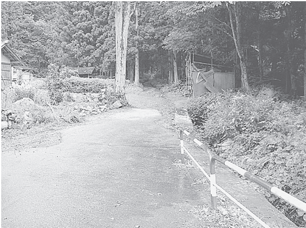
会津美里町東尾岐地区先から未整備・交通不能
