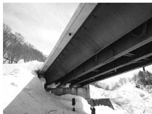
出逢橋の状況
