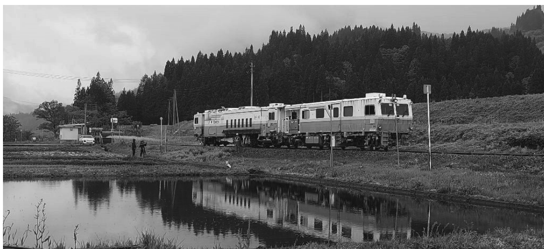
※レールの点検中
