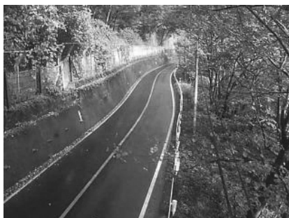
二川橋手前の狭隘な 118 号
