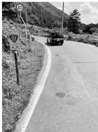
二川橋付近の狭隘な 118 号
