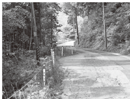
未整備区間（桧原・金山地区）
