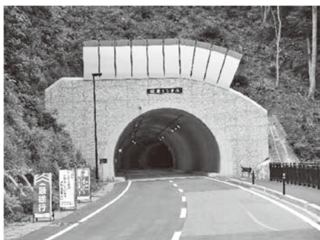
平成26年4月に完成した桧原トンネル
