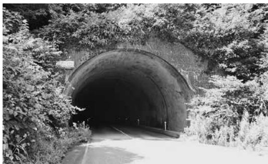
「照明のない白沢トンネル」
