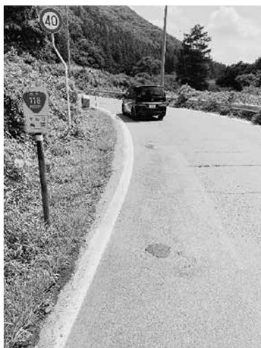
二川橋付近の狭隘な 118 号
