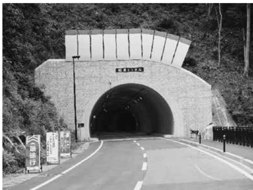
平成26年4月に完成した桧原トンネル
