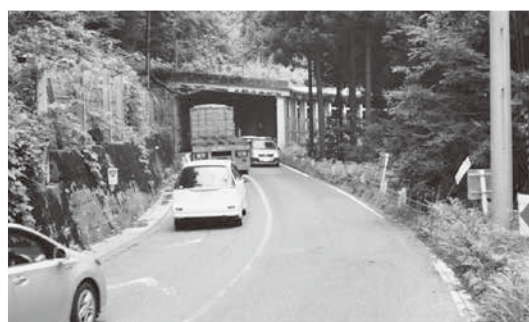
三島町滝原地内のスノーシェッド
