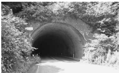
「照明のない白沢トンネル」
