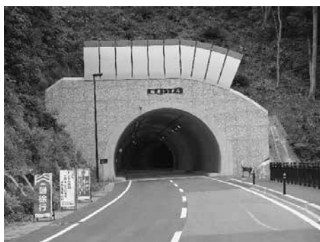
平成 26 年 4 月に完成した桧原トンネル
