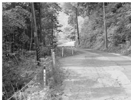
未整備区間（桧原・金山地区）
