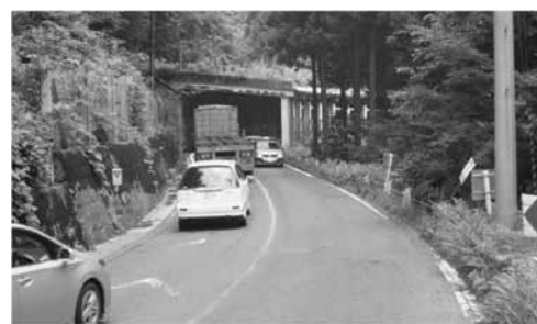
三島町滝原地内のスノーシェッド
